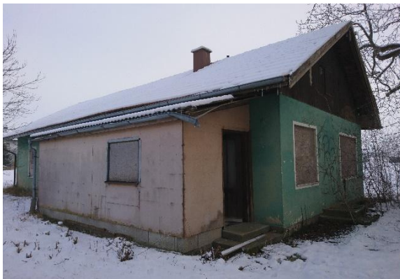
Abb. 7 Abzubrechendes Nebengebäude auf FINr. 2875, Blickrichtung Nordost, Foto: LaN, 12.01.24
