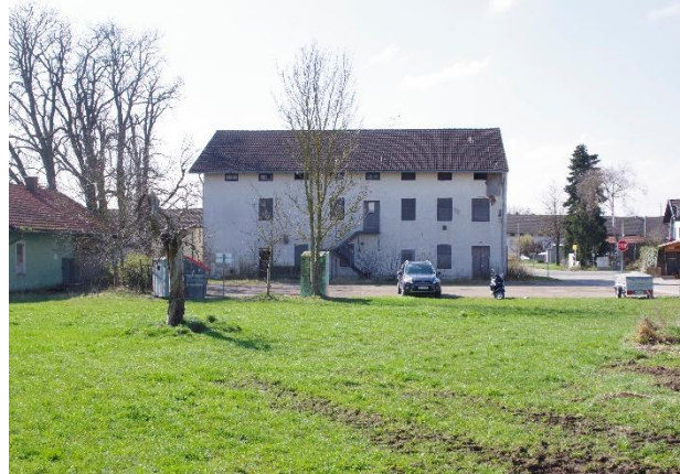
Abb. 6 Bestandsgebäude mit Parkplatzfläche, Blickrichtung Süd, Foto: LaN, 02.04.25
