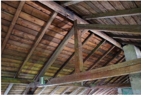
Abbildung 14: Dachstuhl mit potentiellen Hangplätzen und Spaltquartieren, LaN 13.06.2024
