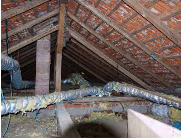
Abbildung 16: Dachboden des ehem. Schützenheims, LaN 13.06.2024
