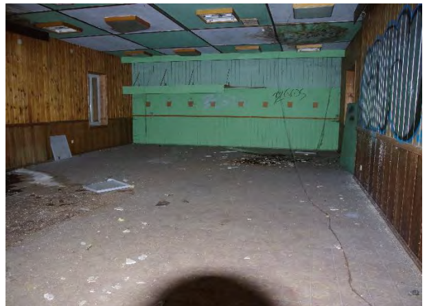
Abbildung 8: Innenraum des ehem. Schützenheims LaN 13.06.2024
