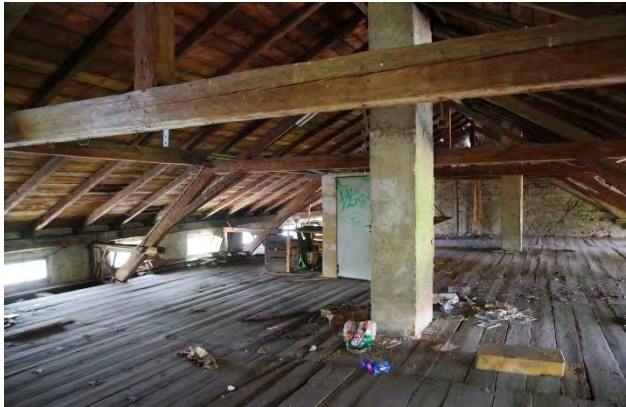
Abbildung 5: Dachgeschoss der ehem. Gaststätte, LaN 13.06.2024
