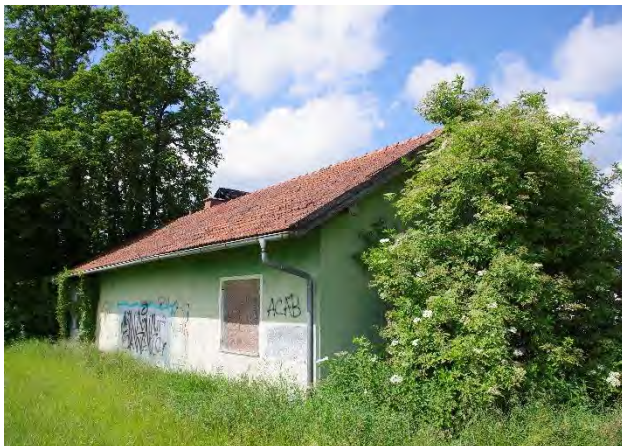
Abbildung 7: Ehem. Schützenheim, Nordostseite, LaN 13.06.2024
