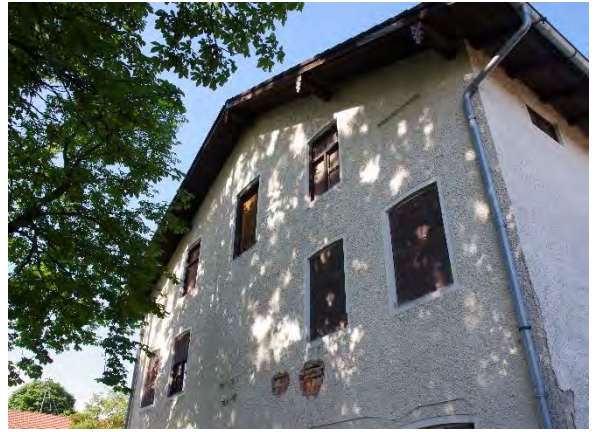
Abbildung 4: Abzubrechendes Hauptgebäude Ostseite, LaN 13.06.2024
