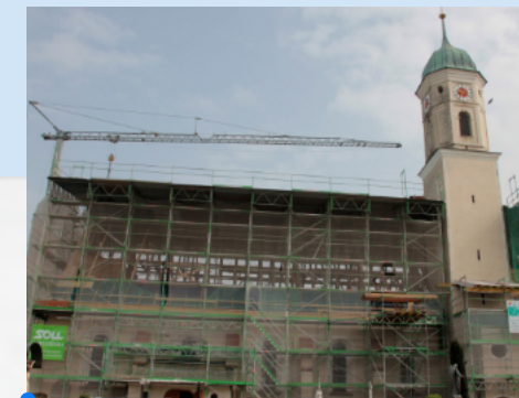
Dachstuhlansanierung der Pfarrkirche
